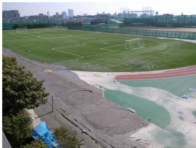
液状化で噴出した砂
